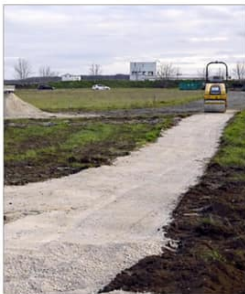
Une piste de 1 000 m, à deux pas de l'aéroport de Nancy/Essey, est en construction depuis le 16 décembre. Photo ER/Cédric JACQUOT
