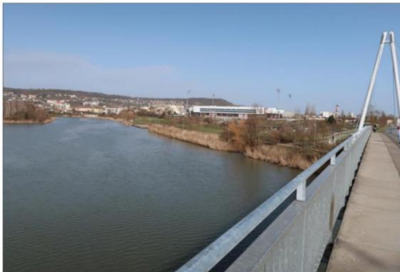
Les bassins, installés côté Picot, feront 25 m de long pour des profondeurs de 1,2 m et 60 cm. Photo ER/Ghislain UTARD
