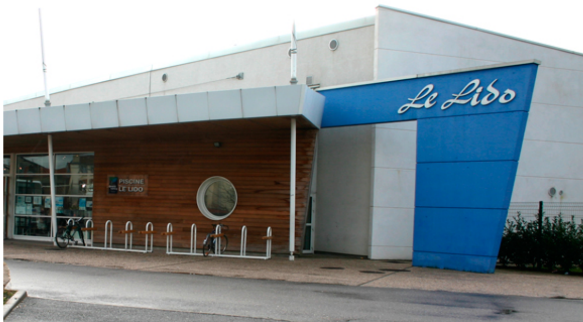
La piscine du Lido à Tomblaine.
