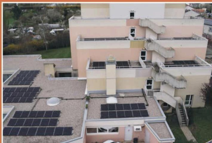
Ces panneaux photovoltaïques auront une capacité de production maximum de 35,89 kWc (kilowatt-crête).
